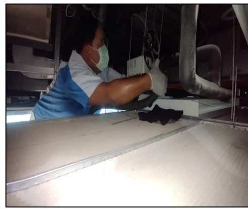
ภาพที่ 4 กิจกรรมทำความสะอาดระบบปรับอากาศ
