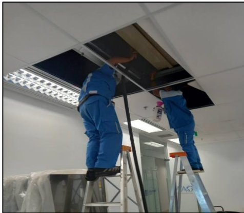
ภาพที่ 4 กิจกรรมทำความสะอาดระบบปรับอากาศ
