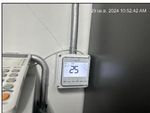
ภาพที่ 5 การตั้งอุณหภูมิเครื่องปรับอากาศที่เหมาะสมและเครื่องปรับอากาศที่มีฉลากประหยัดไฟเบอร์ 5
